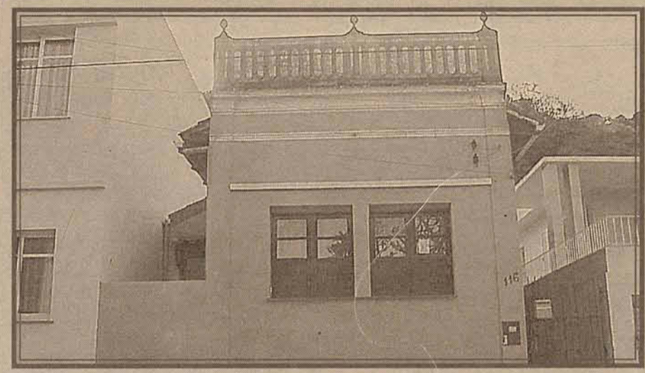
Casa em estilo eclético de transição, presença de platibanda e detalhes de cimbalha e cunhais, porém ainda muito tímidos, mais de acordo com a arquitetura luso-brasileira da qual deve ter se originado, até pelo tamanho de suas esquadrias que não permitem o uso de bandeira fixa, pois geralmente eram do tipo guilhotina. Casa da travessa Luiz Nery, no centro da cidade.
